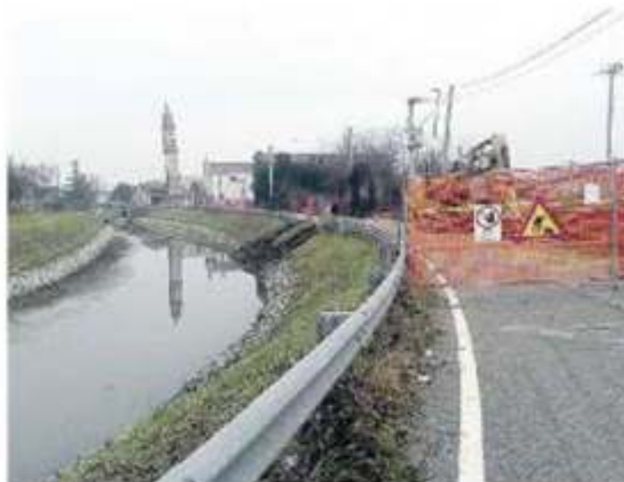
CHIUSA PER LAVORI Via Colombara a Villanova del Ghebbo, i lavori dovrebbero richiedere alcune settimane
