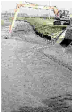
CANTIERE Sono ripartiti i lavori
