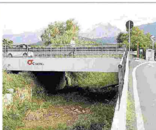
Ponte sul fosso Ricortola
