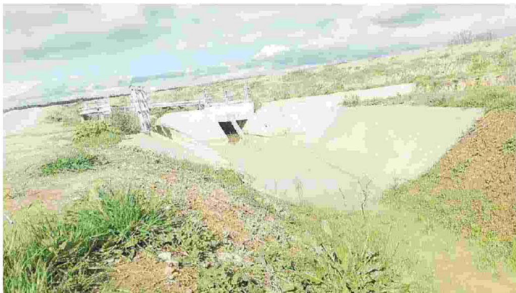
L'Albegna, l'argine remoto (Foto d'archivio)
