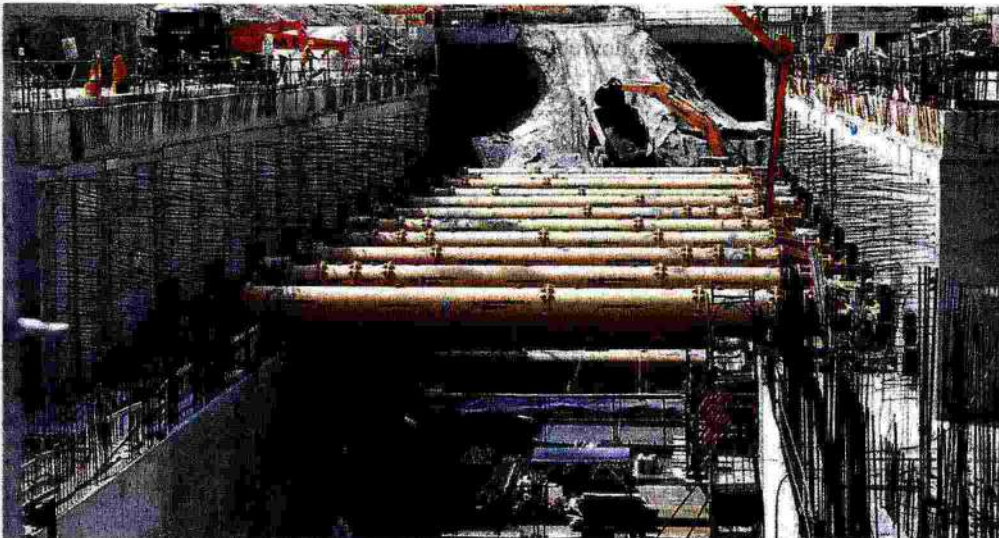
La conca. L'opera di alta ingegneria sul Po a Monticelli d'Ongina (Pc). Sopra, vista dall'alto e, sotto, particolare del cantiere con i puntoni idraulici di 28 metri della britannica Groundforce
