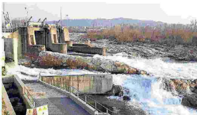
L'opera di presa di Nervesa con l'acqua del Piave che torna a fluire
