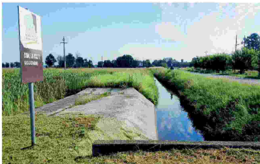
RISULTATI CONFORFANTI Bonifica Lab: uno dei canali oggetto di monitoraggio.
