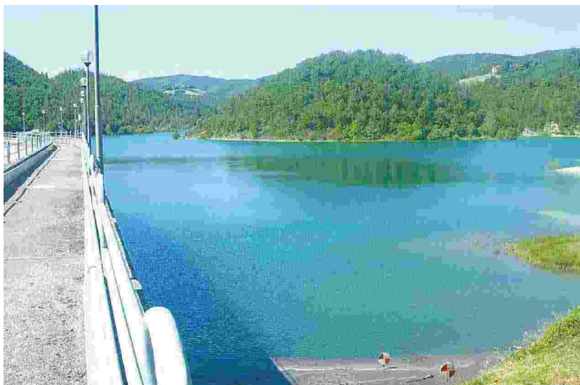
Diga di Arezzo a Spoleto Uno degli impianti che ha destato più interesse tra gli studenti che non conoscevano l'importanza di quest'opera
