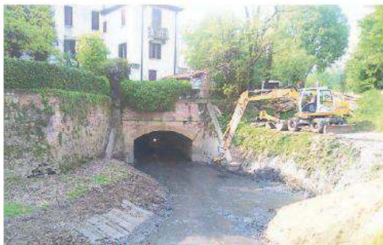
Il cantiere di ripulitura dello sbocco della vecchia botte del Pigozzo
