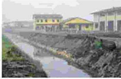
due scarpate dello scolo Nichesola, attraverso il posizionamento di sasso d'annegamento. I lavori, iniziati il 5 dicembre, hanno permesso anche di
