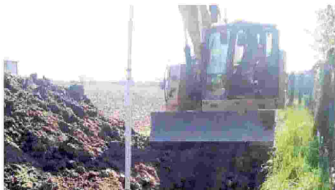
Lavori di escavazione per la sistemazione di un fosso consortile
