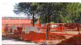
Vicenza, partiti i lavori in Contra' della Piarda
