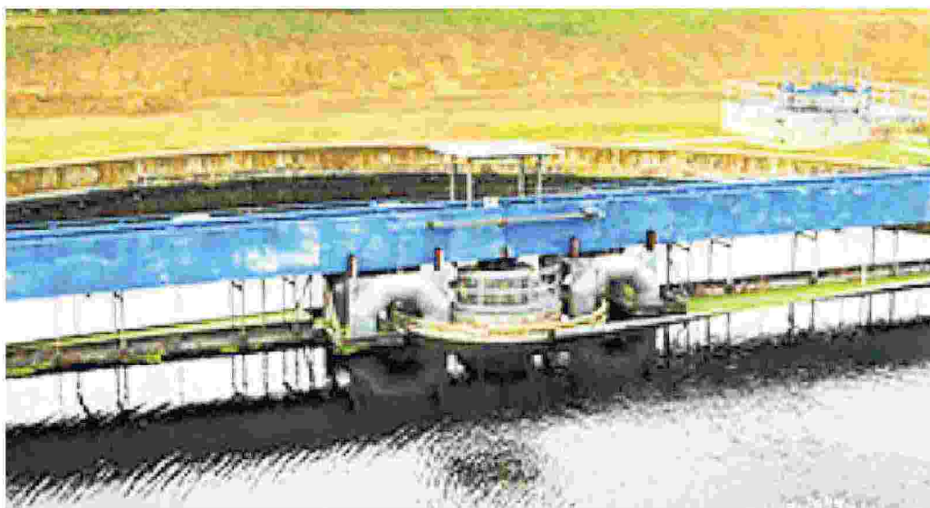
Un impianto di depurazione nelle campagne della Pianura Padana
