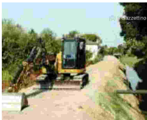
RUSPE Messa in sicurezza degli argini
