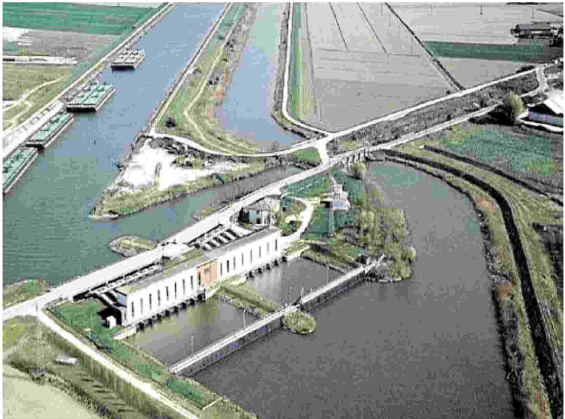
BONIFICA La grande idrovora di Cavanella Po: previsti investimenti per 15 milioni per migliorare il servizio irriguo di tutta l'area
