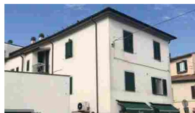
Appartamenti Pontedera Via delle Colline, 12 - 84447
