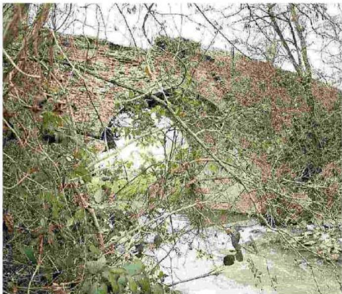
Il ponte del Navazzone è gravemente ammalorato: molte pietre sono crollate
