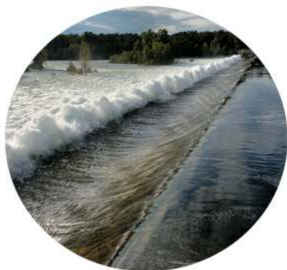
OPERA DI PRESA DEL PANPERDUTO, SOMMA LOMBARDO (VA) *
