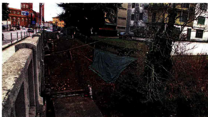
I lavori per la realizzazione della scalinata che scende sulla riva del fiume FOTO CECCON
