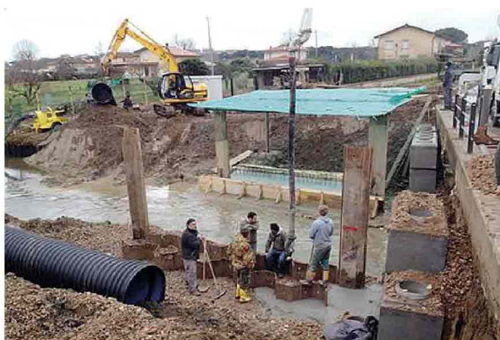
Lavori sugli argini del canale Bagno, lungo via Arginvecchio
