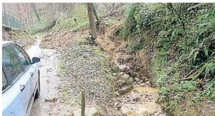
DISAGI Uno degli smottamenti che si sono verificati sul territorio del comune di Massarosa
