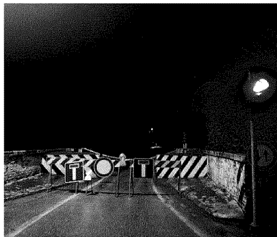
Il ponte sull'Oglio chiuso ad Acquanegra
