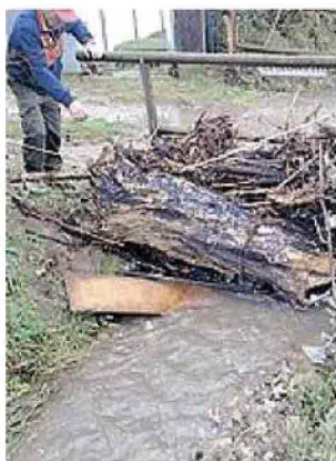
BLOCCATO Un canale ostruito in zona Filettole
