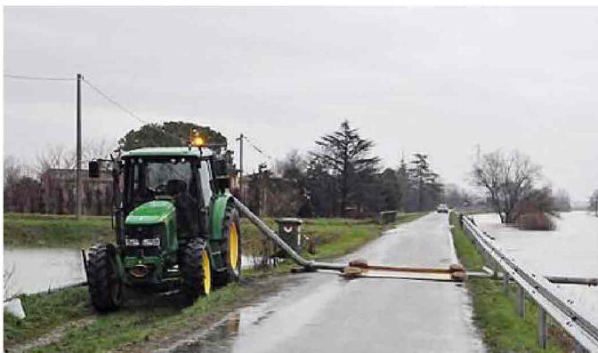
Idrovore in azione per drenare l'acqua nelle campagne allagate
