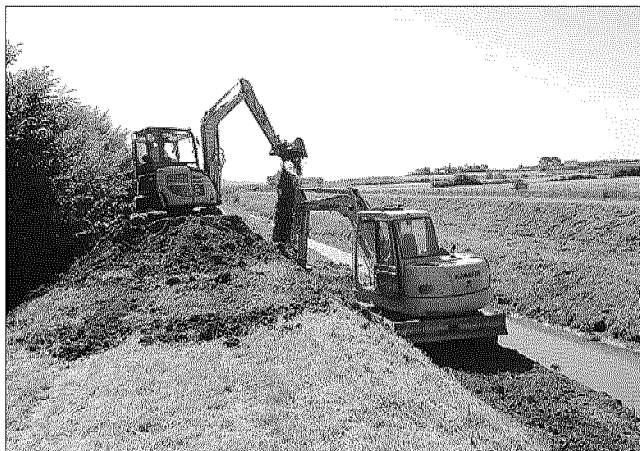
Consorzio di Bonifica La replica dopo il verdetto della Commissione tributaria che ha accettato il ricorso del Comune di Arezzo contro la tassa sui fossi
