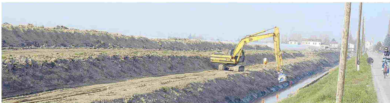
Ruspe al lavoro lungo l'argine, i lavori erano attesi dai cittadini di Castelnovo, Bergantino e Melara
