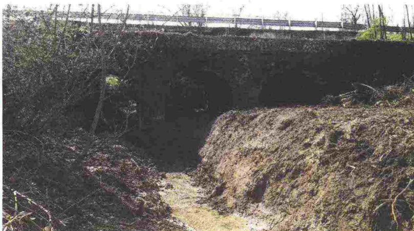
UNO DEI LAVORI ESEGUITI
