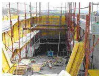
L'intervento in corso per realizzare il sottopasso
