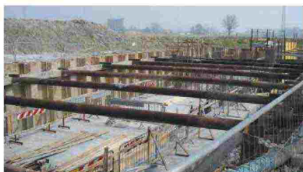
L'ampliamento in atto della roggia Quistra: il lavoro più importante
