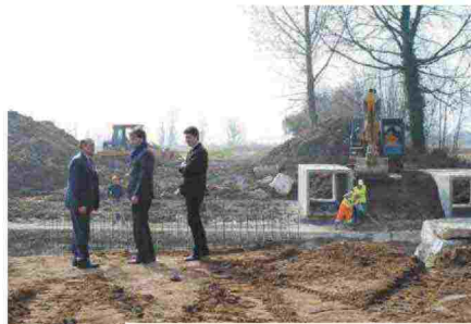
A sinistra e sotto i recenti sopralluoghi dei tecnici e degli amministratori nei cantieri per i due scolmatori che dovrebbero evitare per il futuro gli allagamenti a nord della città
