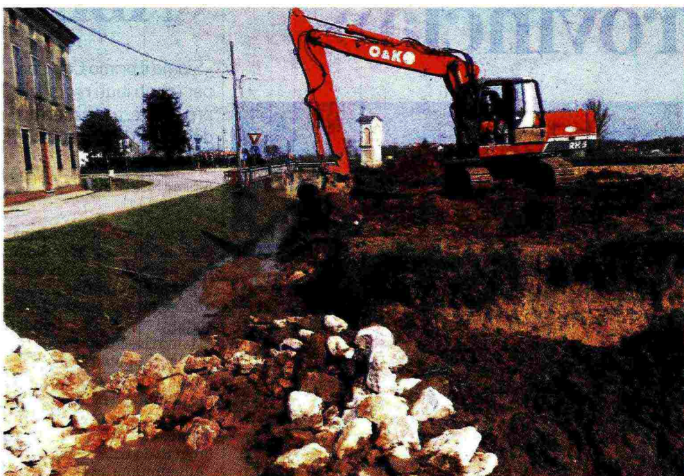
I lavori del consorzio per rinforzare gli argini dello scolo Bacchiglione a Montegaldella
