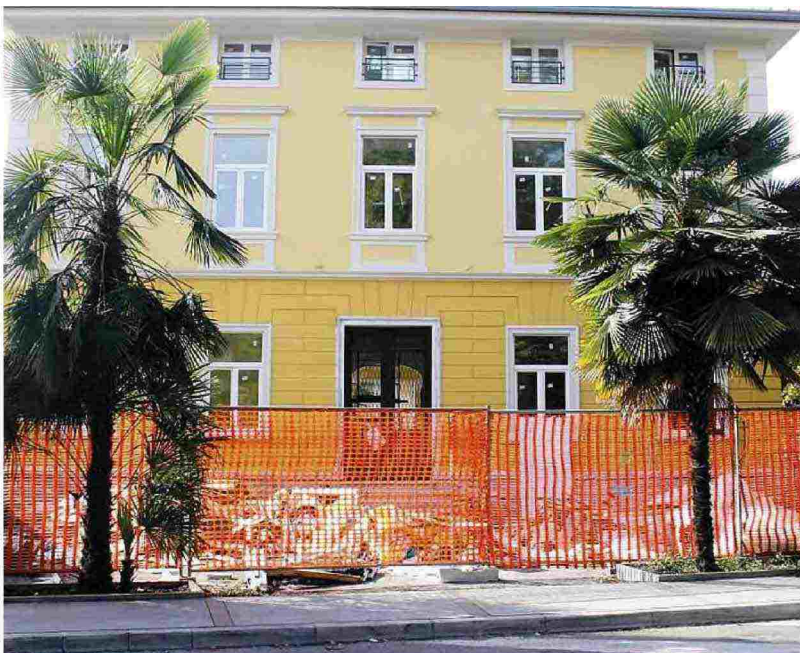
L'immobile destinato ad ospitare la sala polifunzionale ed il museo della Bonifica durante i lavori
