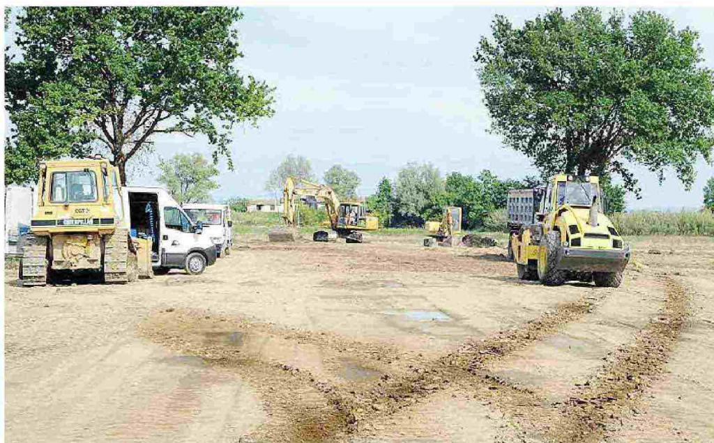
Le ruspe al lavoro nel cantiere della cassa d'espansione alla Querciola (foto Lorenzo Gori)
