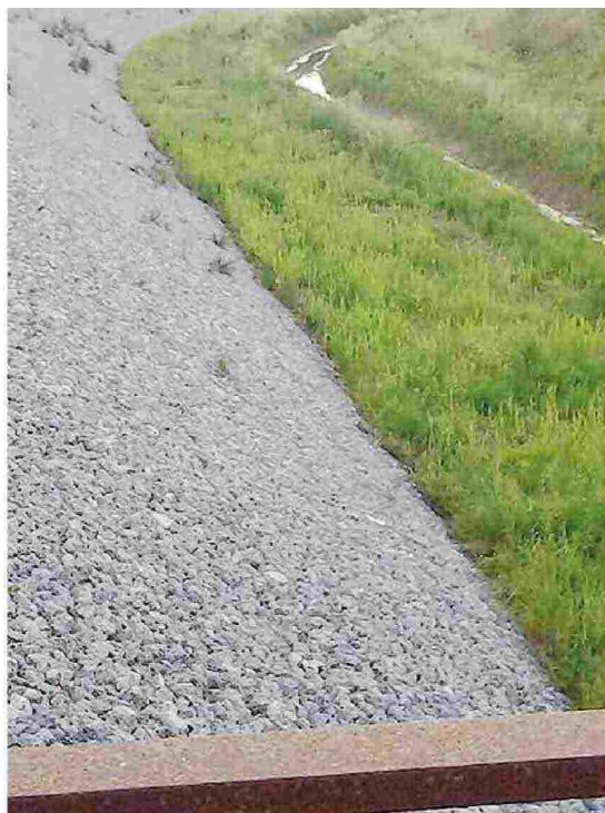
L'argine tipo "Reno" realizzato sull'argine del torrente Magione
