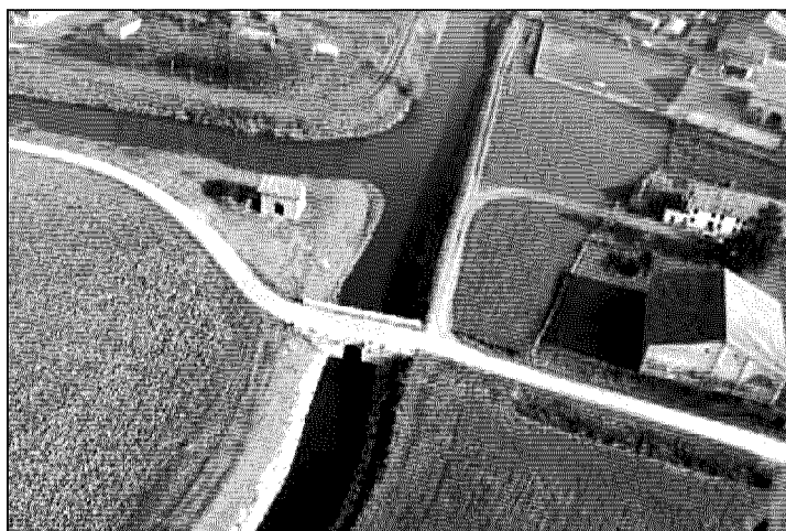
CASTELNOVO BARIANO Il Cavo Maestro che sarà oggetto dei lavori
