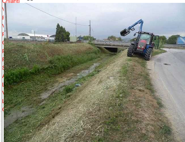
Lavori ai corsi di acqua
