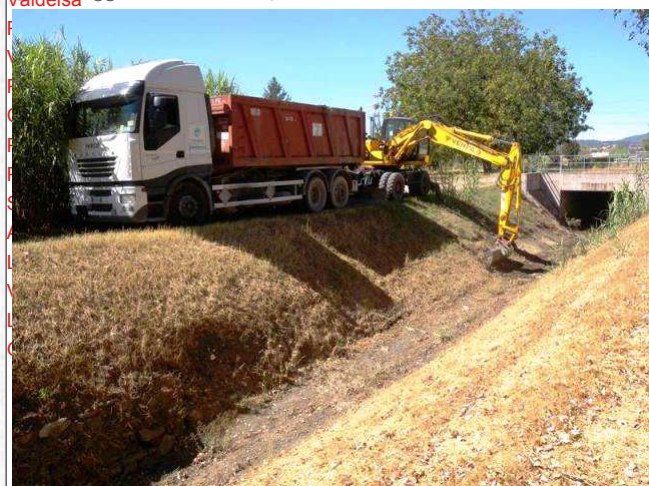
Lavori di un Consorzio di bonifica
