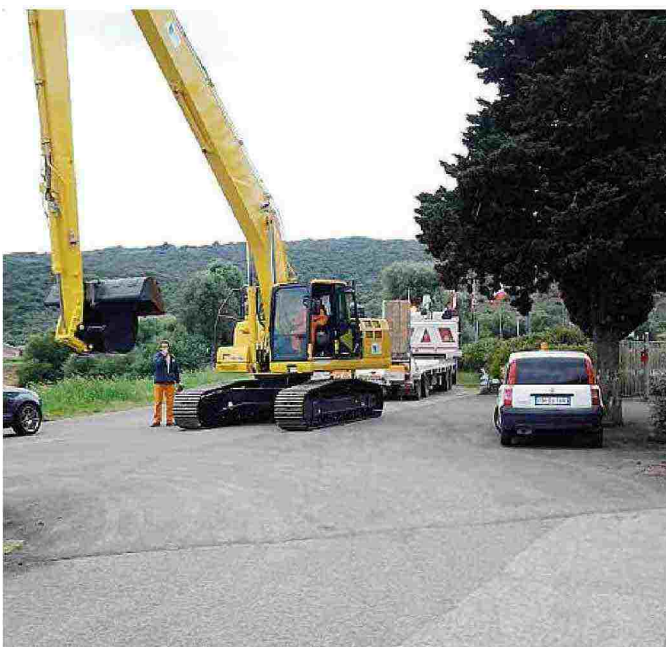
I mezzi escavatori al lavoro in questi giorni al Fossino
