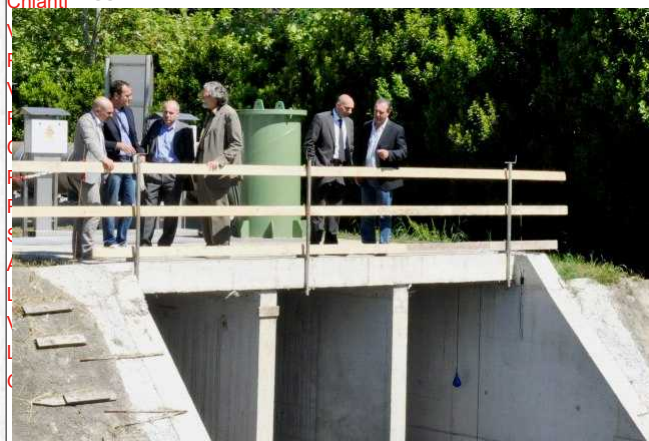
I sindaci del comprensorio e i tecnici di Aquarno osservano il nuovo impianto idrovoro dell'anti-fosso di Usciana (foto gonews.it)
