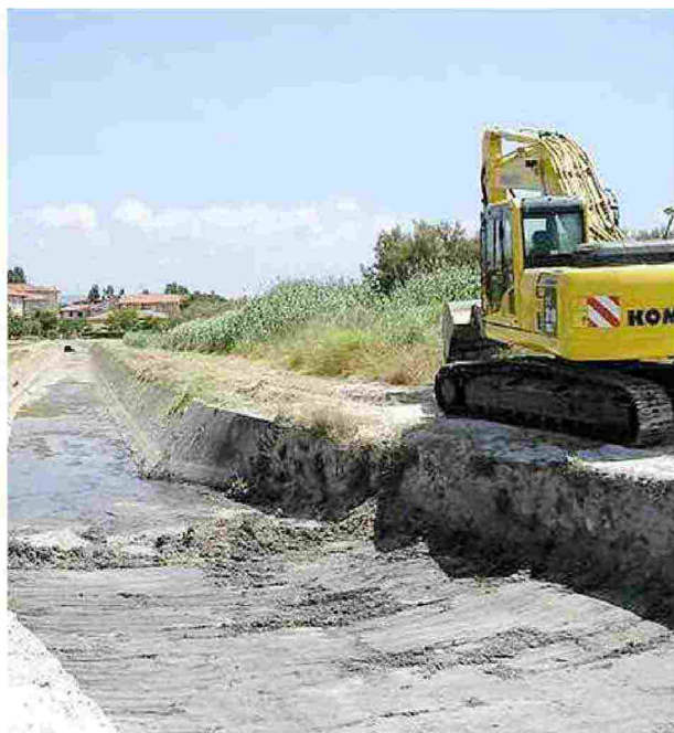
Un intervento di un mezzo della Bonifica
