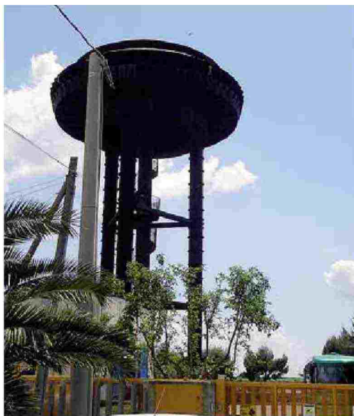
CONSORZIO Una delle due torri piezometriche
