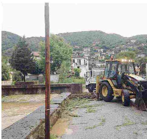
Nella foto un momento dei lavori
