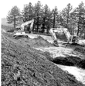
Interventi sugli argini
