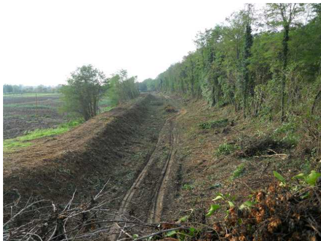
Lavori del Consorzio di Bonifica 1 Toscana Nord
