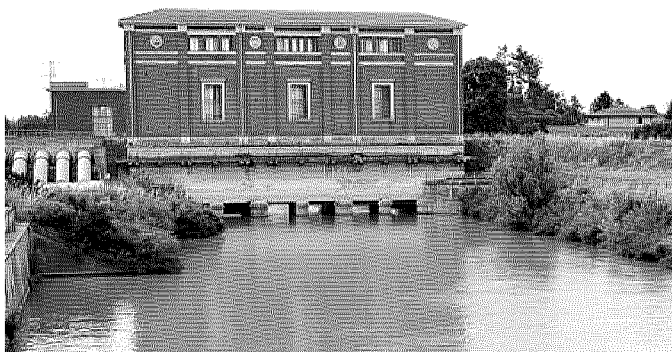
L'impianto di Boretto, la Chiavica della Bonifica
