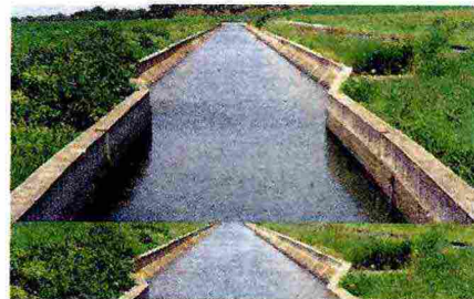
Canale adduttore del distretto irriguo 2B
