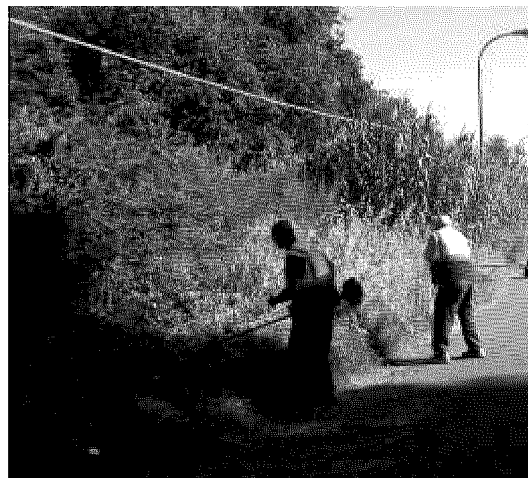
Operai al lavoro
