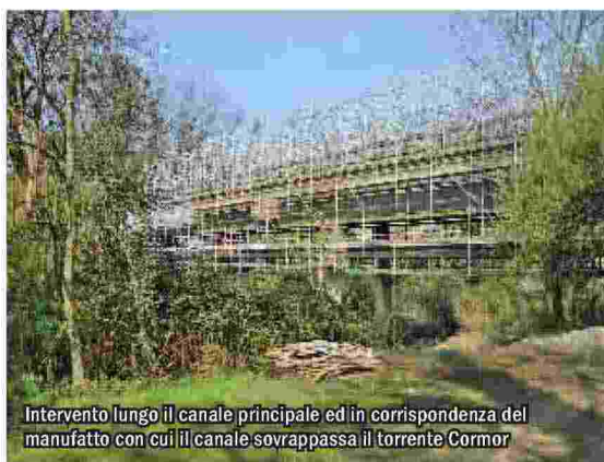
Pronto intervento per il ripristino e messa in sicurezza di un tratto del canale di S. Maria
