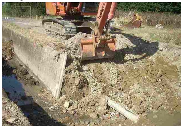
Consorzio di bonifica al lavoro
