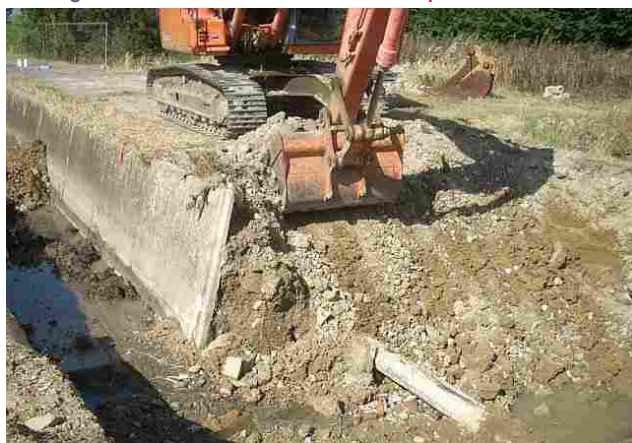
Consorzio di bonifica al lavoro
