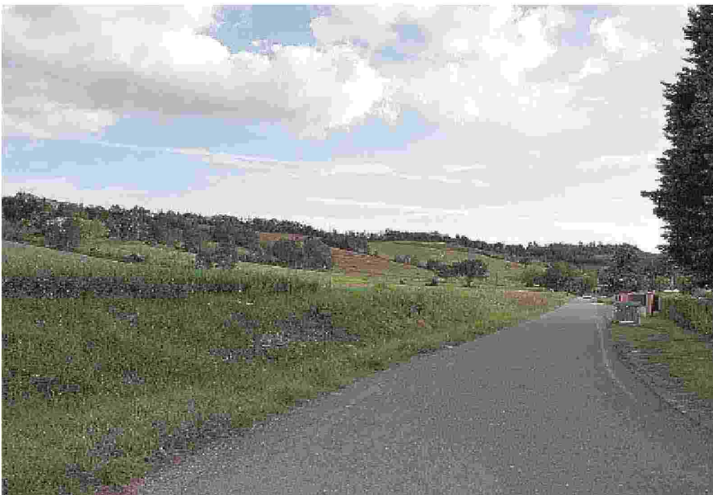
Manutenzione Strada delle Vigne a Gaiano.
