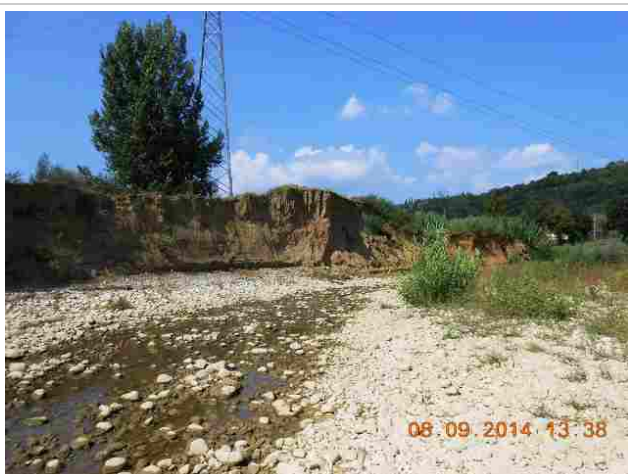
I lavori al Turbone di Montelupo Fiorentino
