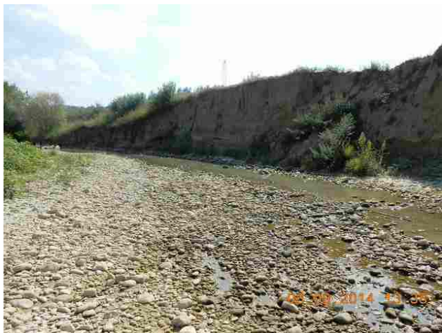
I lavori al Turbone di Montelupo Fiorentino
