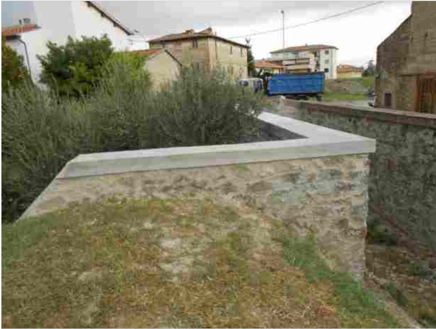
L'intervento sul Borro della Guardiana a Lastra a Signa
