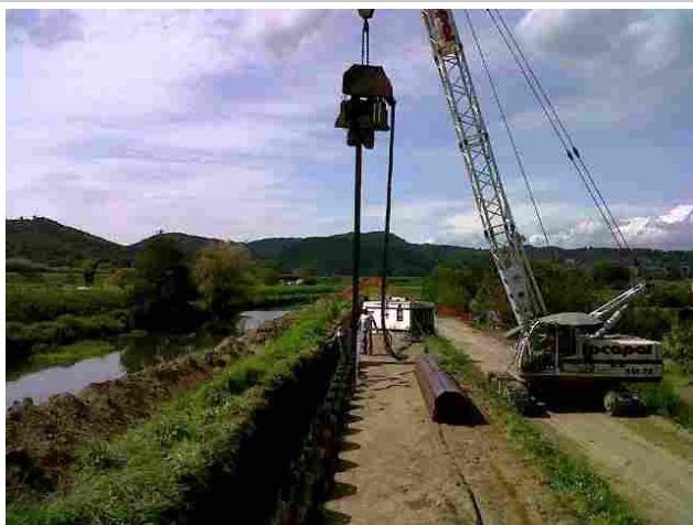
L'opera di consolidamento
