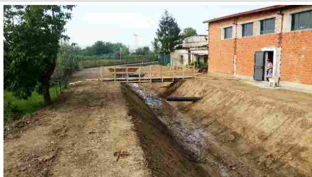
I lavori a Ficarello, Montemurlo
