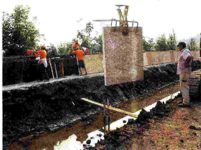
Lavori allo scolo Mutti: rialzato l'argine e rivestita la sponda FOTO AMATO
