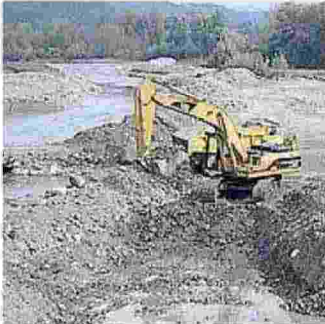
LAVORI Una ruspa in azione
