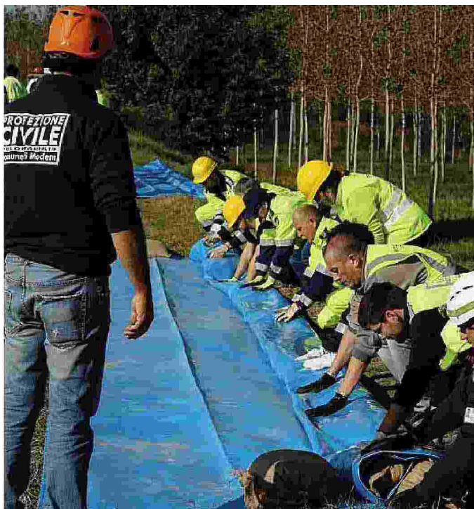
Un intervento della Protezione civile con i teloni lungo un argine
