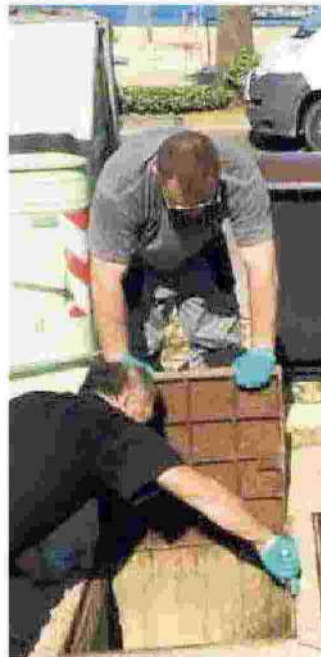
Controlli in un pozzetto
