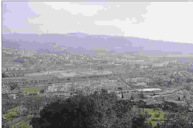
Orvieto Scalo L'area interessata dai lavori
