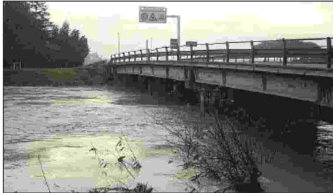
Il ponte sul fiume Savio fra Ravenna e Cervia
