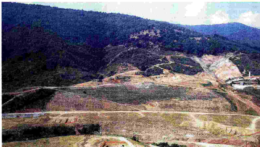
L'area in cui si prevede la costruzione della diga sul Melito. Secondo i numeri sulla carta la struttura dovrebbe avere la capacità di contenere 108 milioni di metri cubi d'acqua
