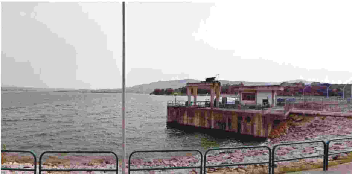
Gli impianti di distribuzione idrica della diga Jato, a Partinico. (*FOTO MIGI*)
